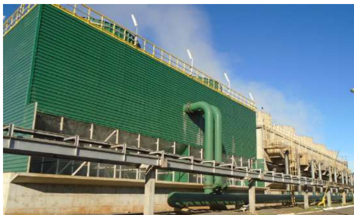
Figura 3 – Foto da torre de resfriamento
